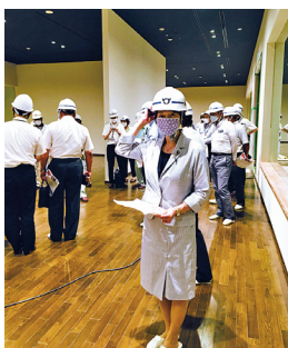
令和3年6月再開館を目指して改修工事中の近代美術館を視察。
